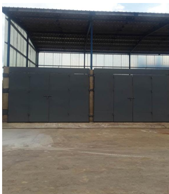
图 2 一般固废暂存间
