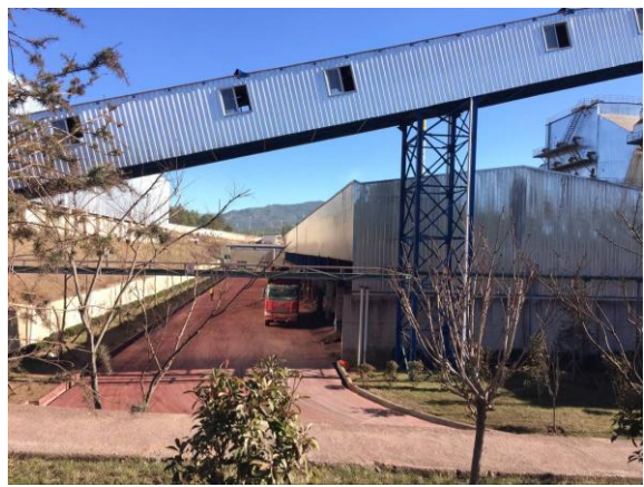
图 4 铁焙砂储存区
