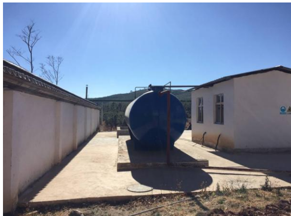
图 1 一体化生活污水处理站
