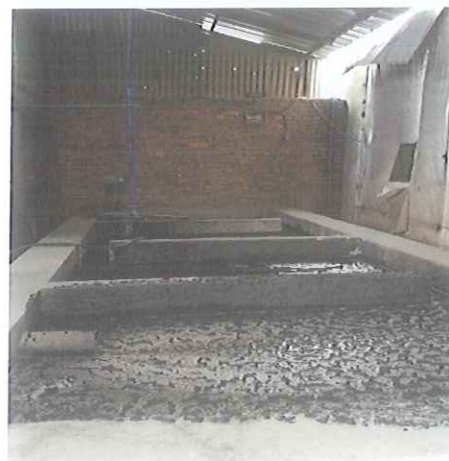
除尘水沉淀池
