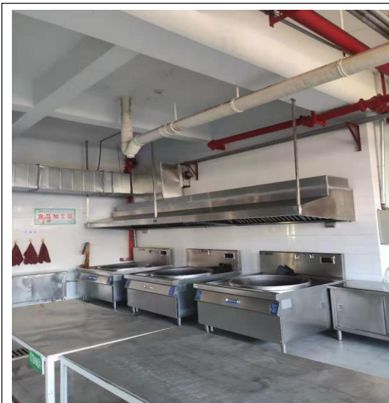
食堂灶头现状
