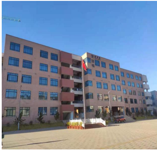
教学楼（清源楼）
