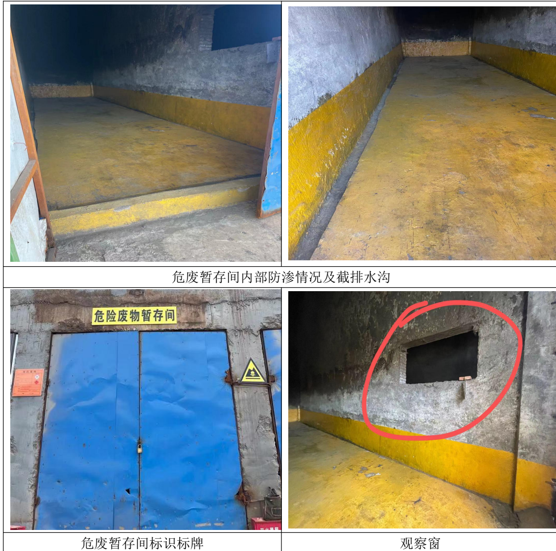
图 1 危废暂存间整改现场情况
