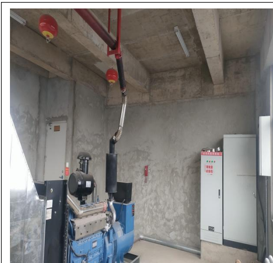
厂房抽排风系统
