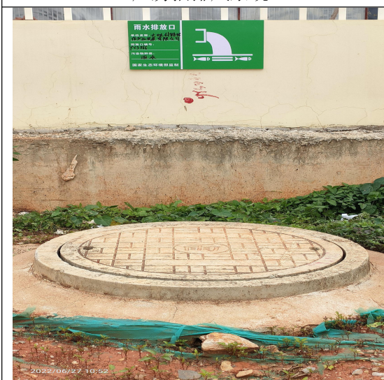
项目区雨水排放口
