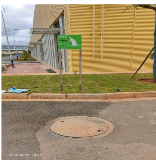
项目区污水排放口
