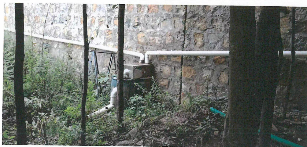
整改后雨水收集管及收集桶照片（增设了一个简易油水分离器）
