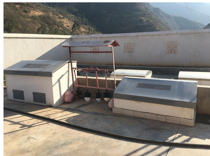
卸油口、消防沙箱
