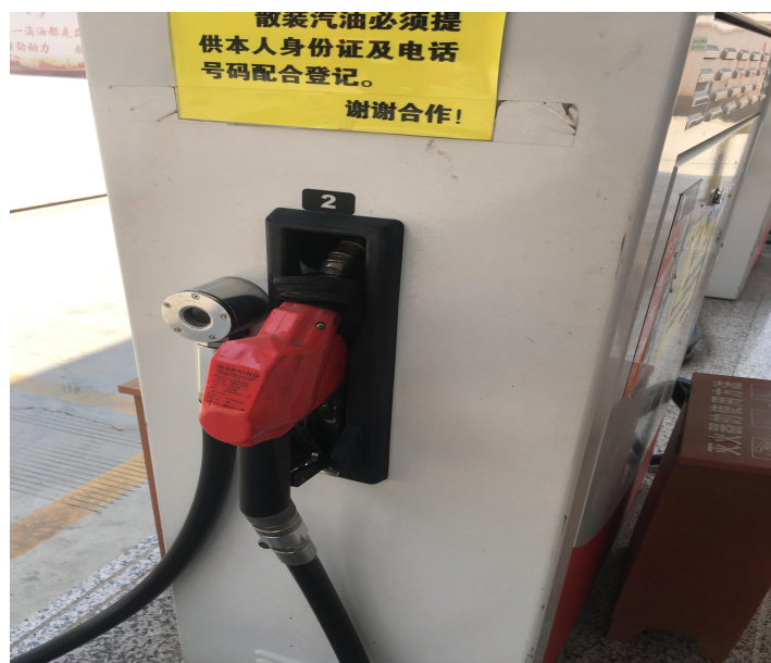
加油枪油气回收装置
