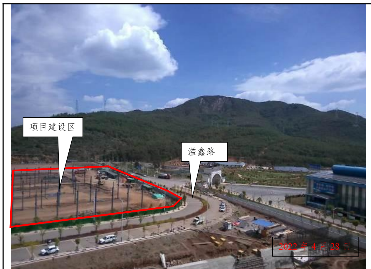
项目建设区东侧现状
