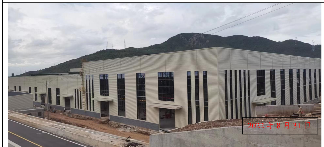
项目建设区内建设现状
