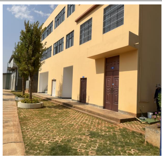
净水厂综合楼
