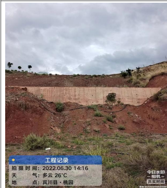
大水井泵站弃渣场
