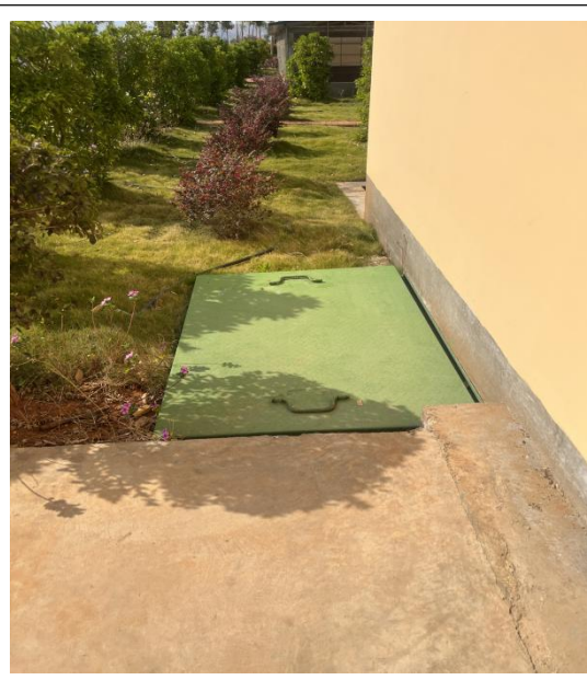
加药间事故收集池
