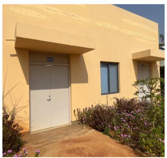
泵房及配电室
