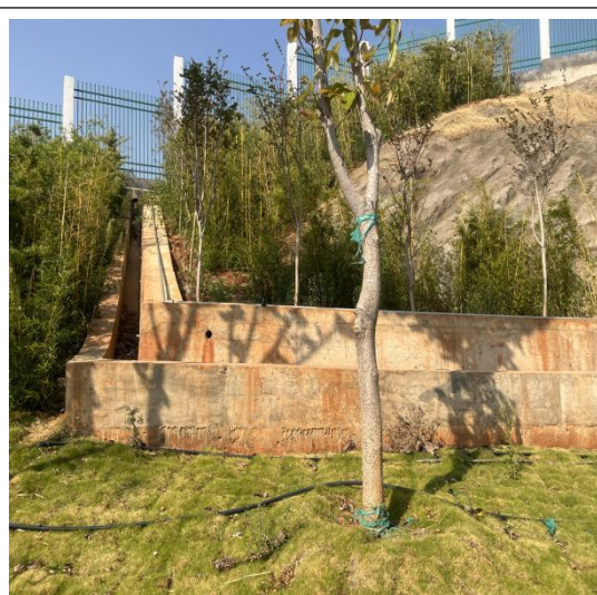
净水厂雨水沟
