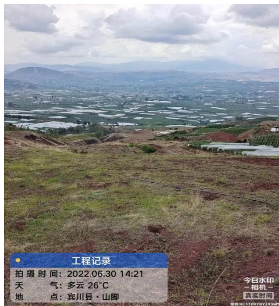
大水井泵站弃渣场生态恢复情况
