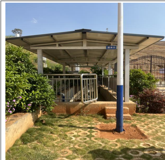
净水厂进水口
