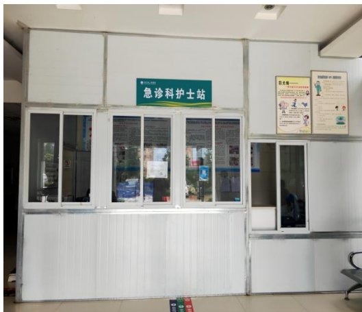
改建区域现状
