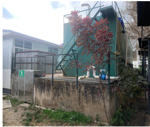
污水池出水处及排污口
