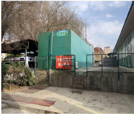
改造后的污水处理站
