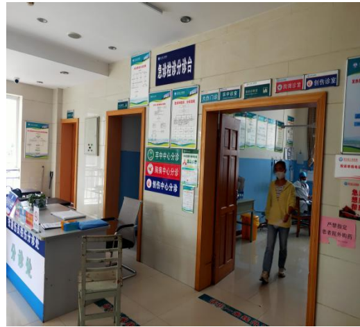
改建区域现状
