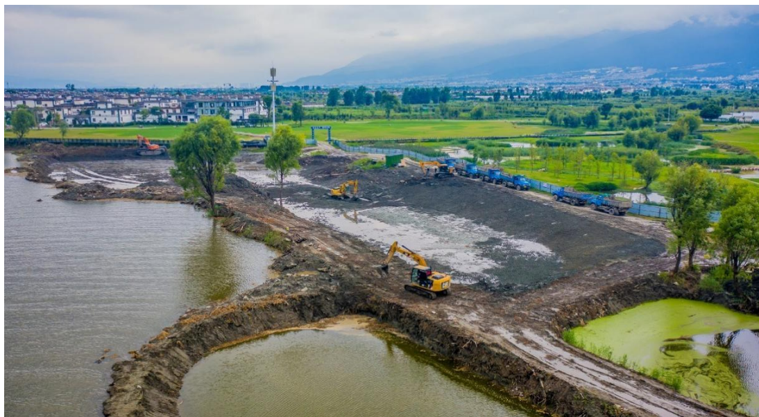
图 3.2-10 塘埂拆除工程施工照片
