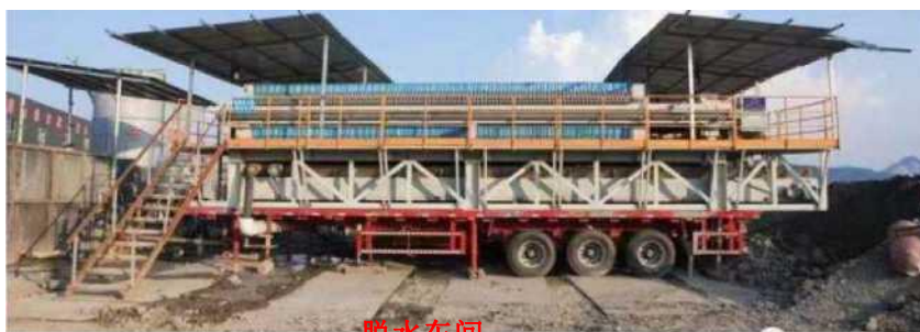
图 3.1.6-25 脱水车间 超高压移动式板框脱水系统
