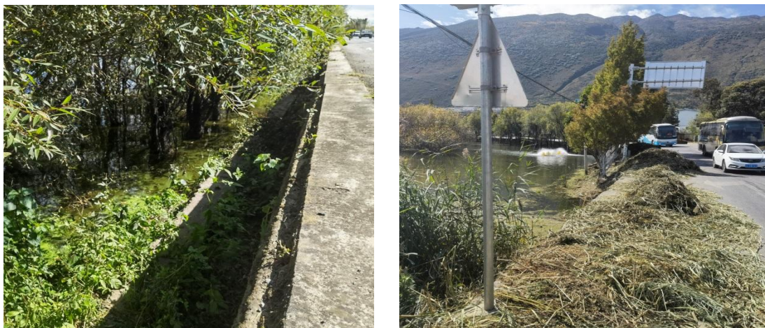
图 3.1.2-4 西沙坪湾岸线现状
