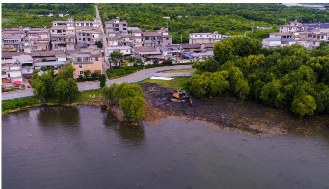
图 3.2-5 清漂清障施工照片
