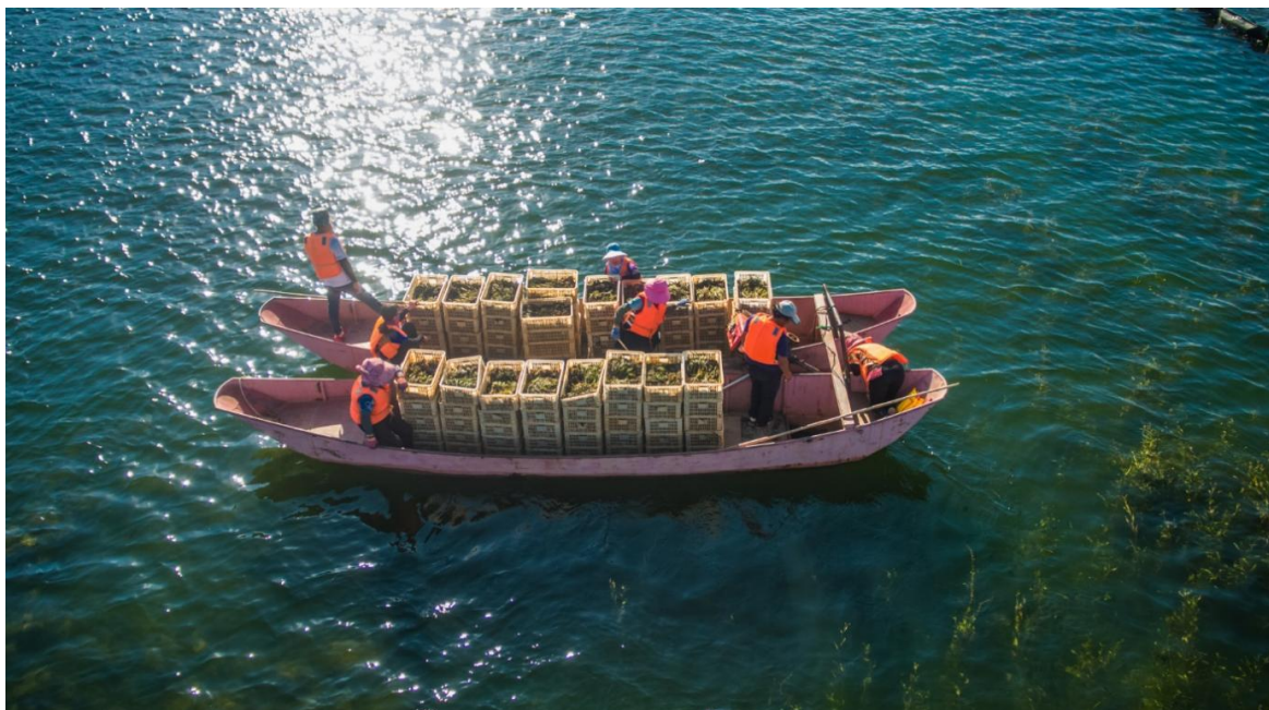
图 3.2-17 沉水植物种植施工照片
