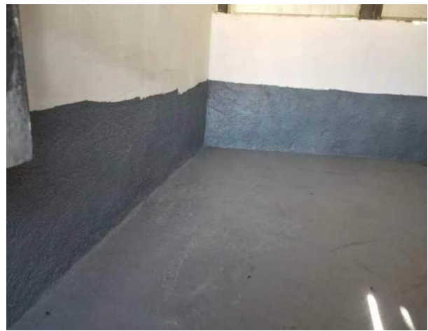
危废暂存间重点防渗
