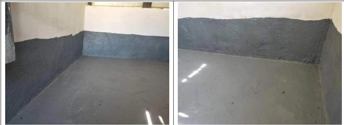
危废暂存间地面进行重点防渗
