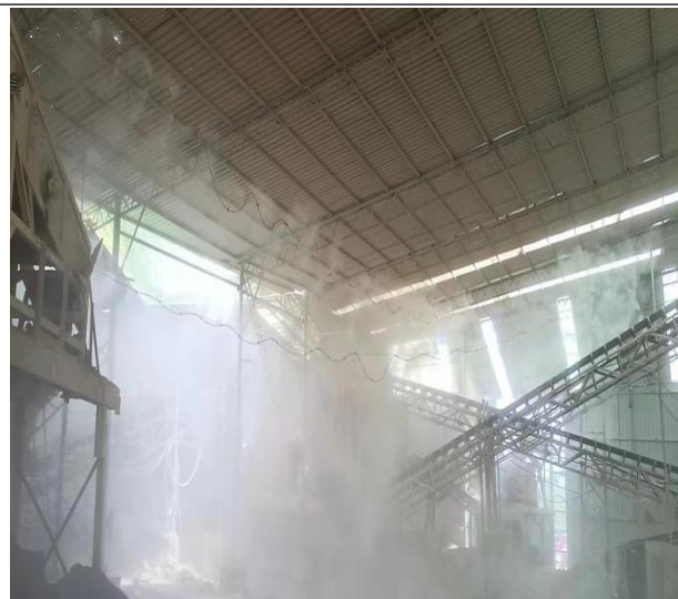
喷雾降尘设施作业情况
