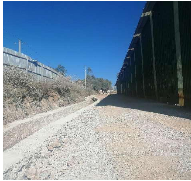
厂内道路及排水沟
