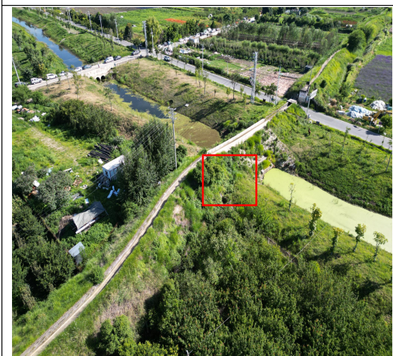
才村新建泵站位置
