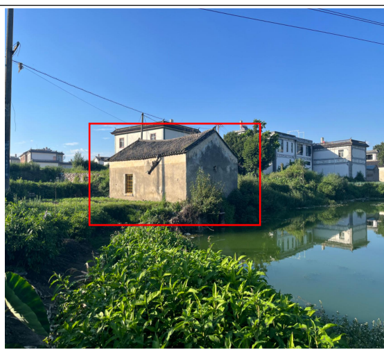
下兑村修复泵站
