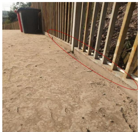
门卫室西侧雨水围挡
