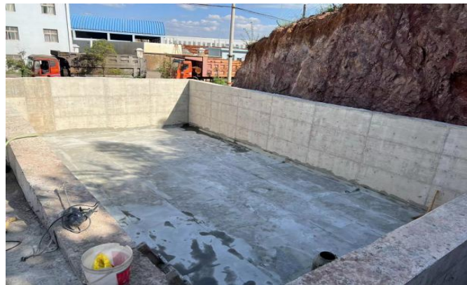
初期雨水收集池
