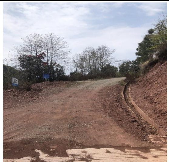
上坝公路现状
