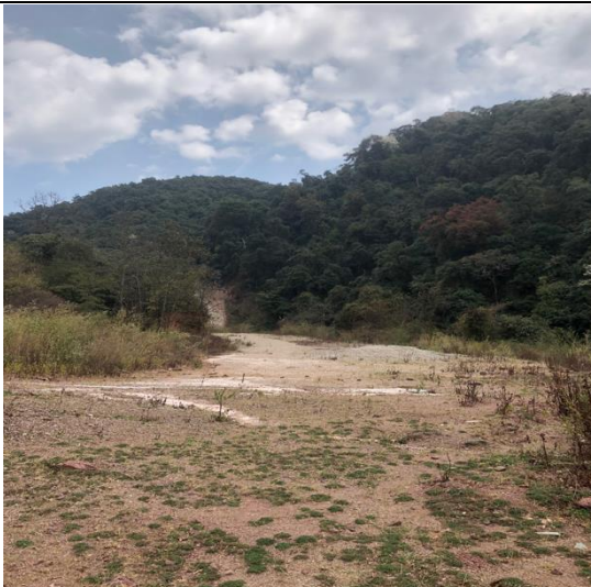
施工生产区恢复现状
