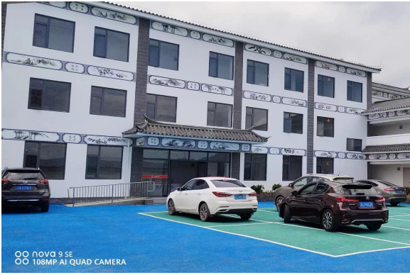
项目新建办公楼
