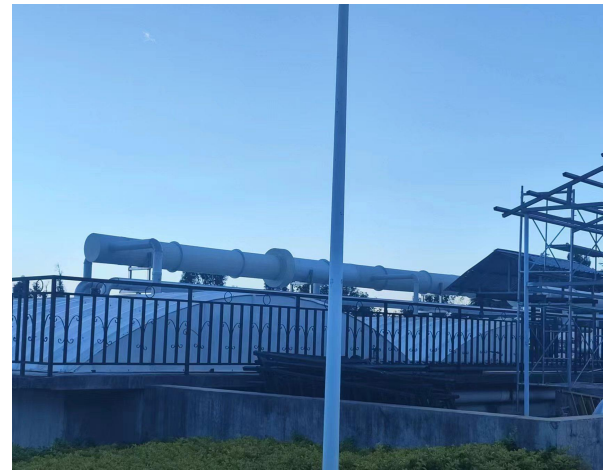
污水处理站生化池
