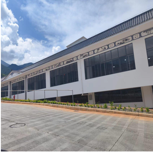
项目生产车间
