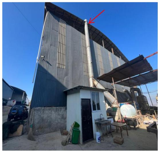
废气处理装置排气筒（15m）
