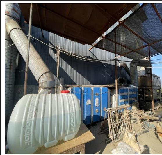
废气处理装置（气旋喷淋+活性炭+UV 光解）
