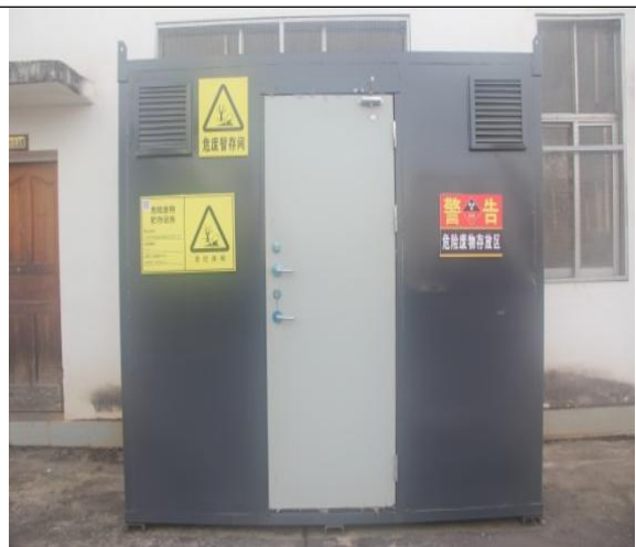
危废暂存间（涂装车间）
