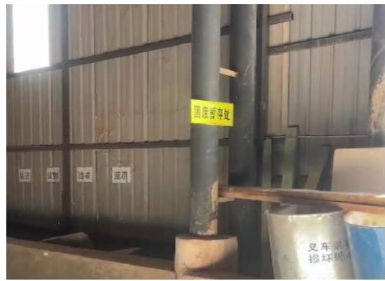
一般固废暂存区整改后
